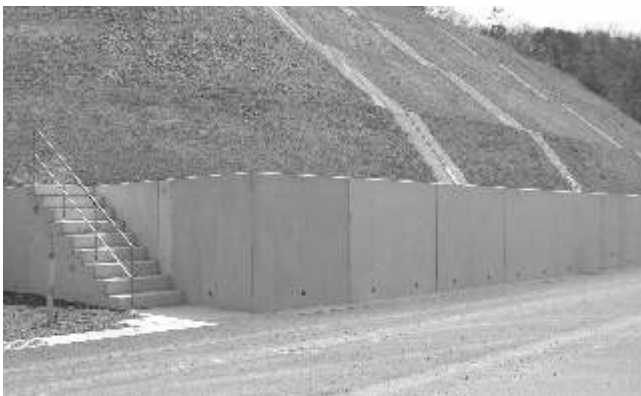
民間造成工事(瀬戸内市虫明地内)
