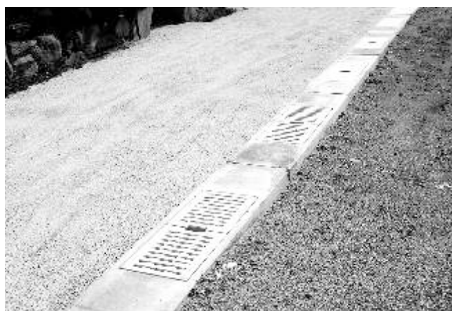
(岡山市藤崎地内)
