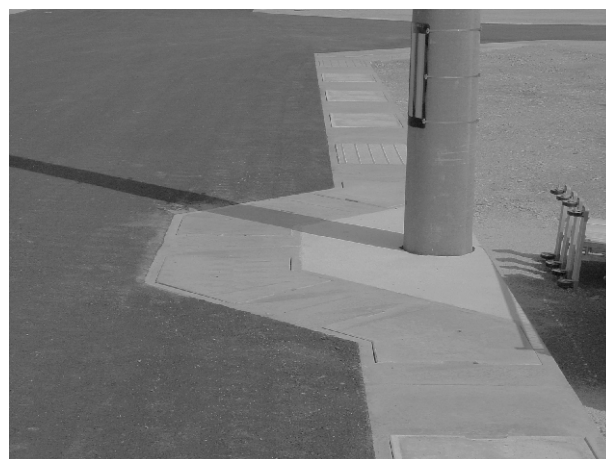
民間工事(大高地区)
