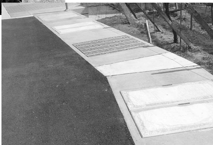
民間工事(谷尻地区)
