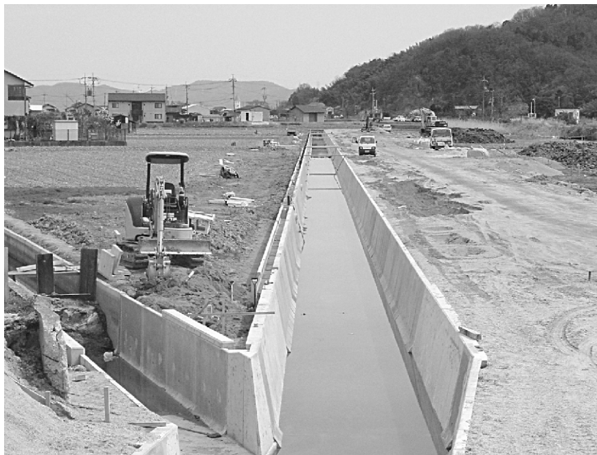
備前県民局 公共河川改修工事
