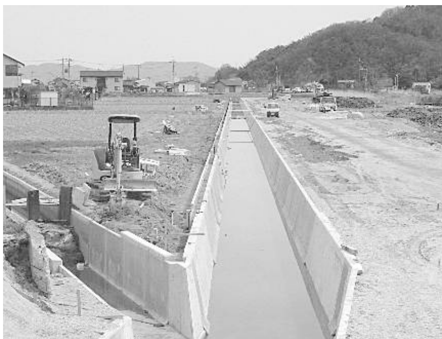
備前県民局 公共河川改修工事
