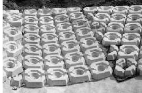
間詰めブロックによる処理
