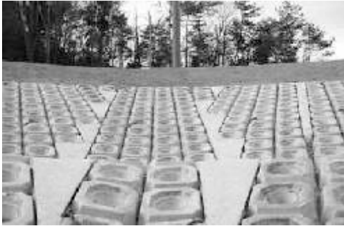
現場打ちコンクリートによる処理
