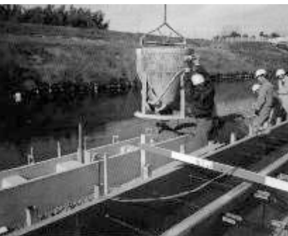
7. コンクリート打設
