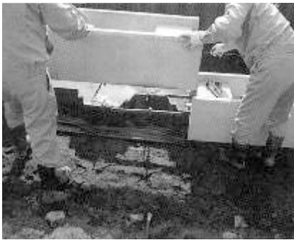
5. 底型枠受けブラケットの取り付け
