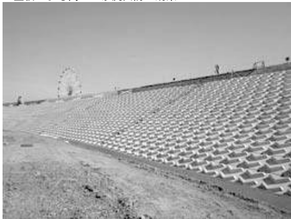
V型棧による高い土砂流出防止効果
