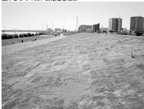
護岸としての高い安定性を確保
