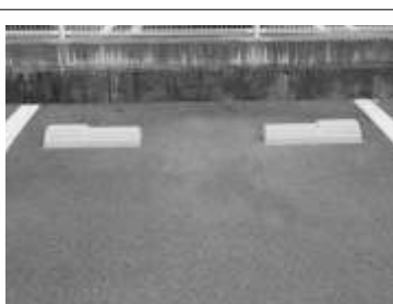
⑧24時間以上養生した後、車止めブロックとして使用していただけます。
