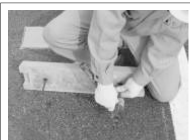
⑥ワンタッチ差筋アンカーをブロック底面の穴に差し込み、ハンマーで打ち込んで固定させます。
