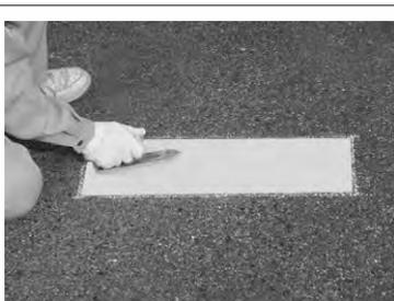
⑤設置箇所全面に接着剤をコテ塗りします。（厚さ2mm程度まで。厚塗りしますと硬化が遅くなりますのでご注意ください。）
