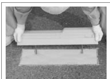
⑦アンカー穴に差筋が入るように調整しながら、ブロックを設置します。
