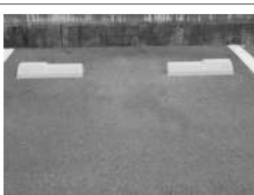
⑤24時間以上養生した後、車止めブロックとして使用していただけます。
