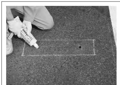
④アンカー穴にグラウトもしくは専用接着剤（ナルシルバー）を充填します。
